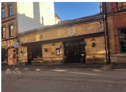
Figur 13. Byggnad på Nordhemsgatan 24, byggnad A. Foto stadsbyggnadskontoret.
