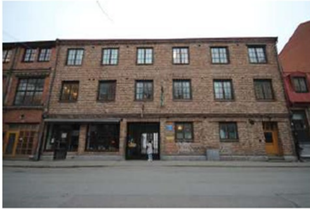
Figur 15. Byggnaden på Tredje långgatan 13. Byggnad C. Foto Lindholm restaurering.
